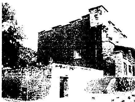
紅毛城外観 写真中央から左下の白い石積の内側が庭院で、その奥の一階部分に監獄が四つ設けられている。
